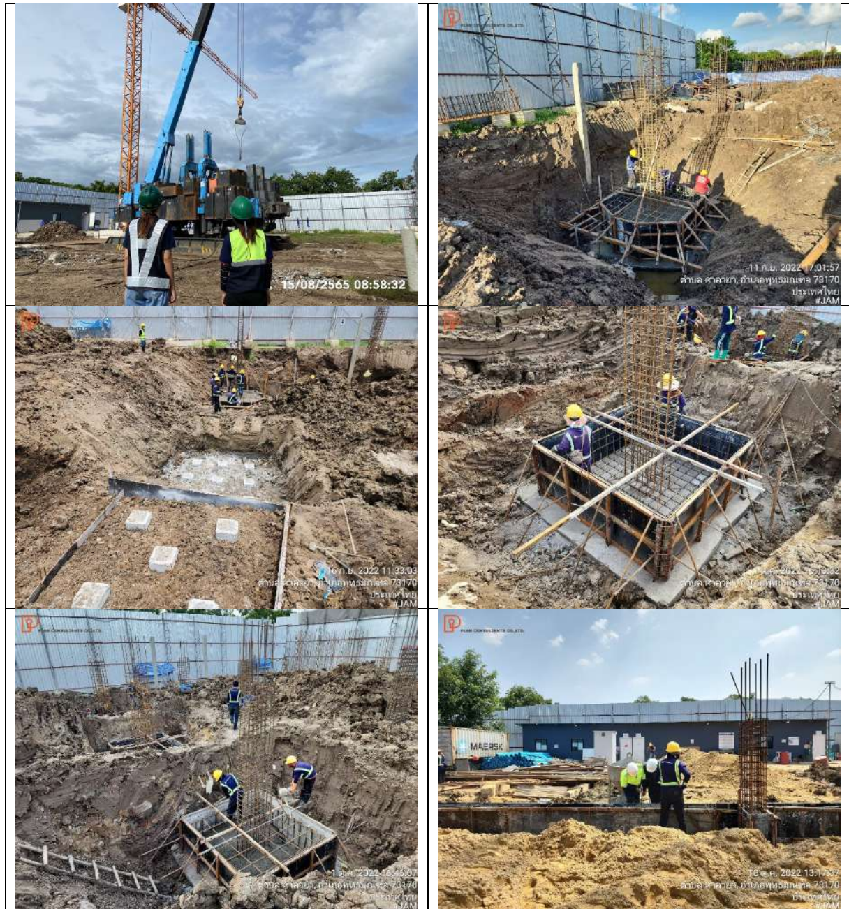
รูปที่ 2-11 การดำเนินขุดเสาเข็มและฐานราก (ระยะการก่อสร้างอาคารหอพักเจ้าหน้าที่ (หอ 2))
