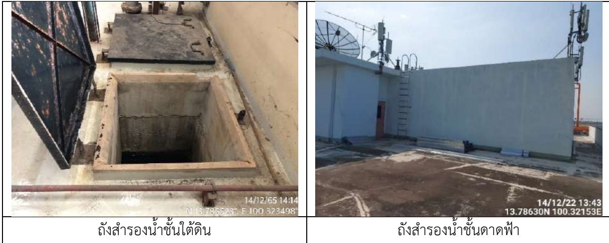
รูปที่ 2-46 ถังสำรองน้ำประปาบริเวณชั้นใต้ดินและชั้นดาดฟ้าของโครงการ (ระยะดำเนินการ)
