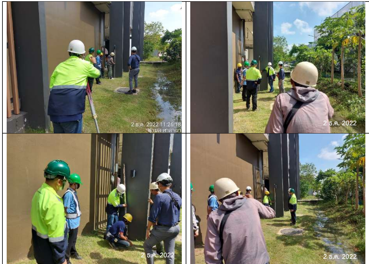
รูปที่ 2-6 การตรวจสอบการทรุดตัวของดิน (ระยะการก่อสร้างอาคารหอพักเจ้าหน้าที่ (หอ 2))
