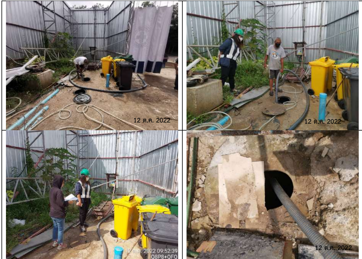
รูปที่ 2-18 การสูบลากตะกอนระบบบำบัดน้ำเสีย (ระยะการก่อสร้างอาคารหอพักเจ้าหน้าที่ (หอ 2))
