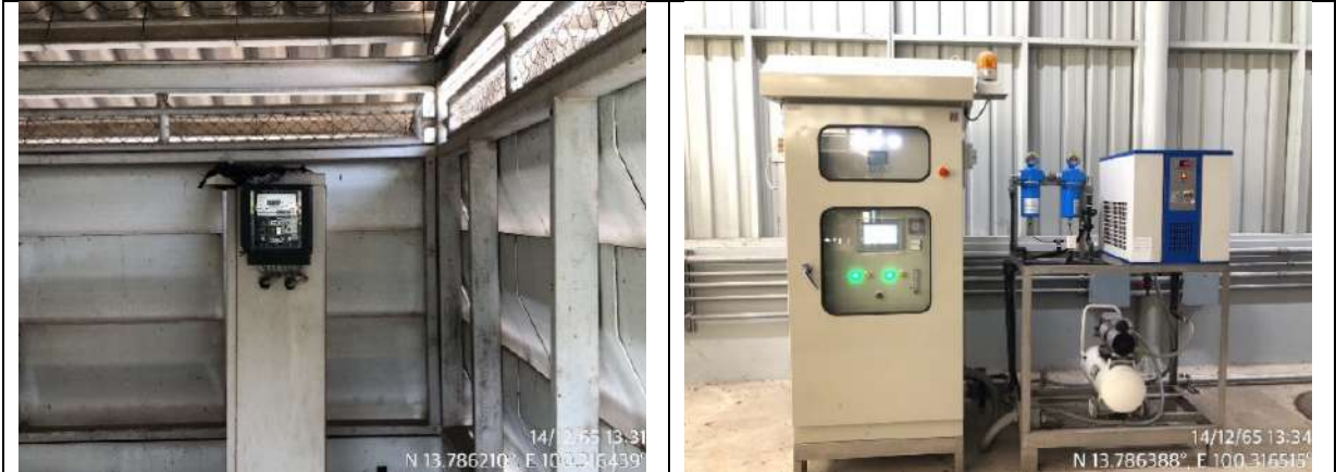
รูปที่ 2-49 การติดตั้งมิเตอร์ไฟฟ้าของระบบบำบัดน้ำเสียและการควบคุมการทำงานของระบบบำบัดน้ำเสีย (ระยะดำเนินการ)
