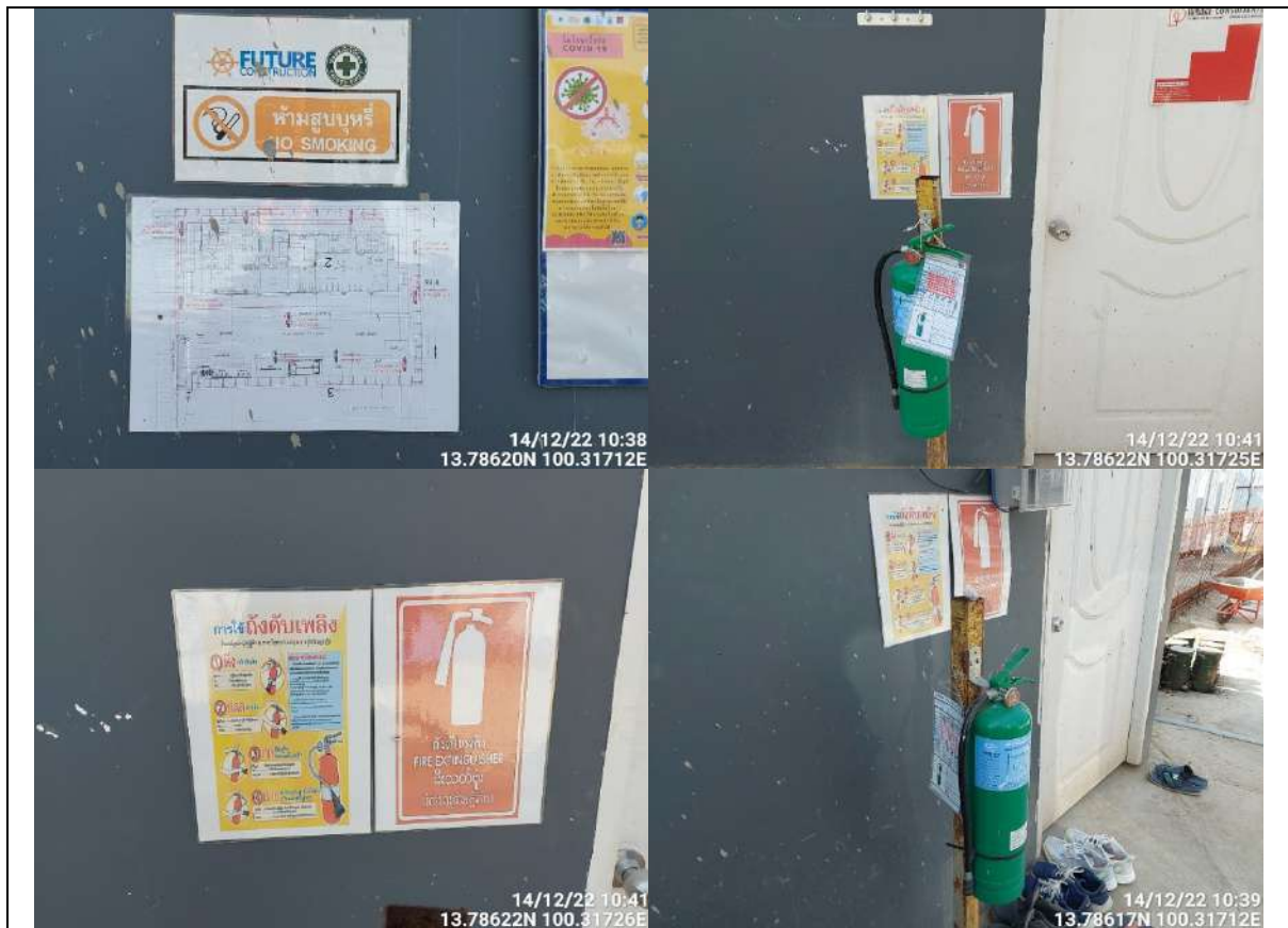
ตัวอย่างการติดตั้งถังดับเพลิงบริเวณพื้นที่ก่อสร้าง
